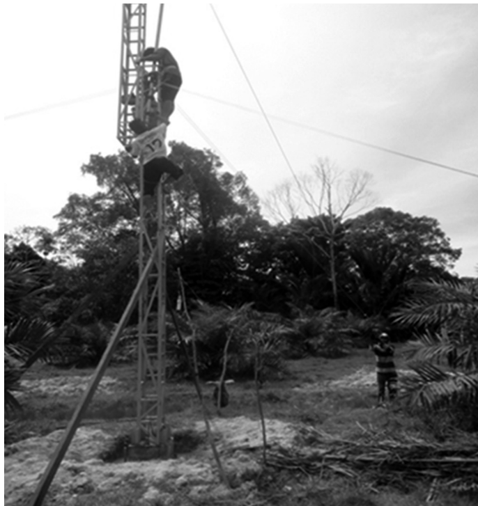
ภาพที่ 3 การสร้างฐานตอม่อและติดตั้งเสากังหันลม
