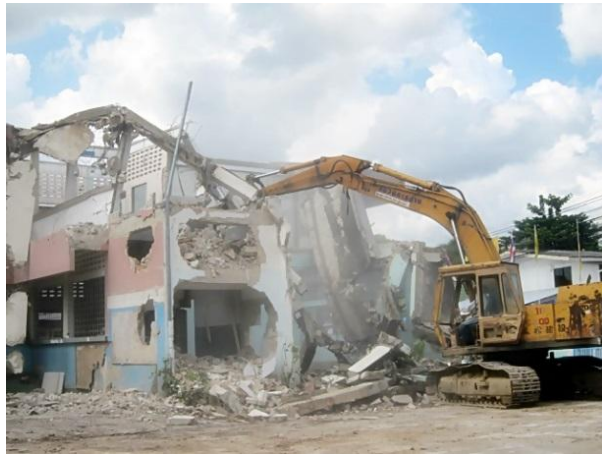
ภาพที่ 5 งานรื้อถอนอาคาร
