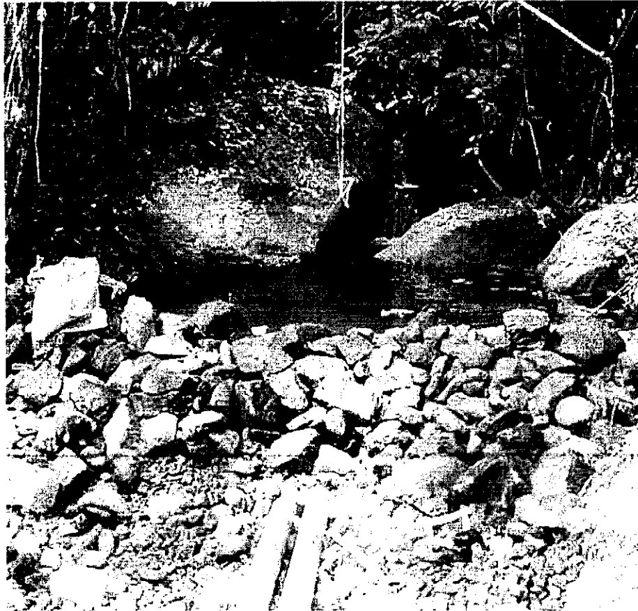
ฝายกั้นลำธารด้วยก้อนหิน (ตัวอย่างที่ชาวบ้านสร้างเองได้ง่าย) เพื่อยกกระดับหัวน้ำให้สูงประมาณ 1.25 เมตร
