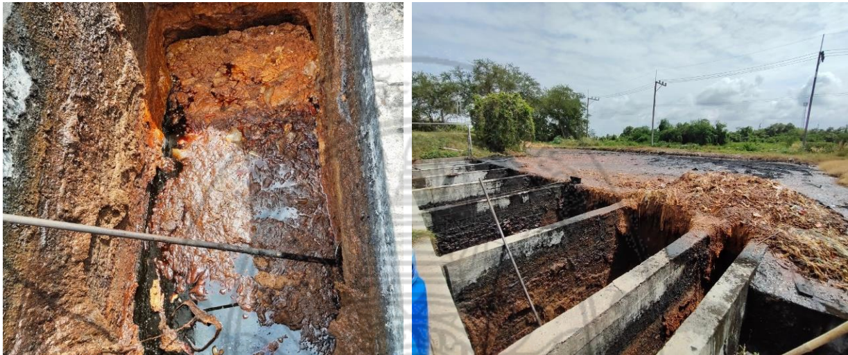
ภาพที่ 2.2 กากไขมันจากปอดักไขมันอุตสาหกรรมปลากรอบ
